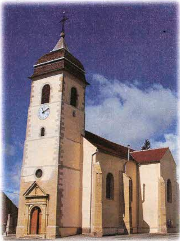
Toiture et ravalement de l'église
