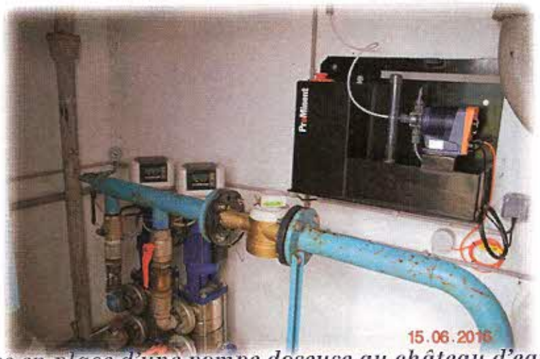
Mise en place d'une pompe doseuse au château d'eau.
