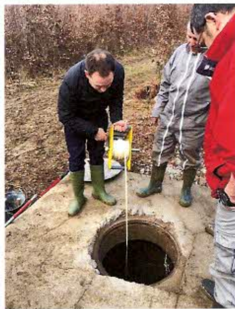
Travaux au captage avec l'hydrogéologue.
