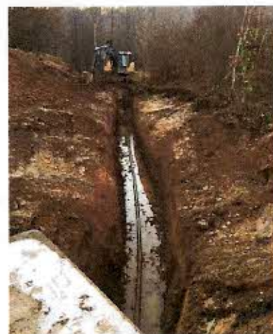
Remplacement d'un drain au captage.
